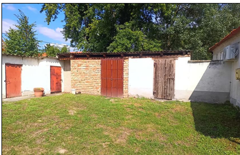
A telek északkeleti részén lévő bontandó épületek
